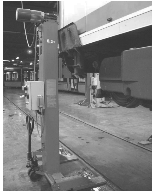
Photo 4 : Colonne d'extrémité en phase de levage
